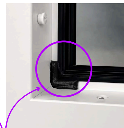
Nurk mastiksiga töödeldud Corner treated with mastic sealant
