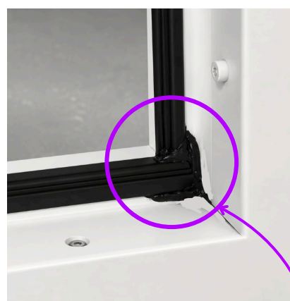
Nurk mastiksiga töödeldud Corner treated with mastic sealant
