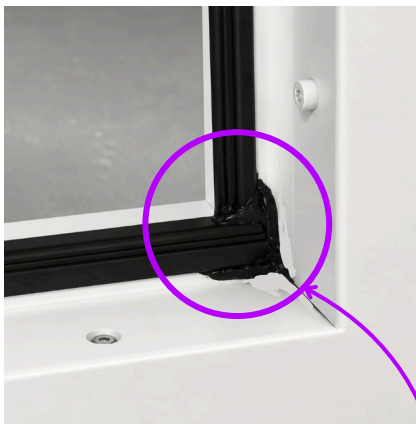
Hörn behandlat med mastix Hjørne behandlet med mastik
