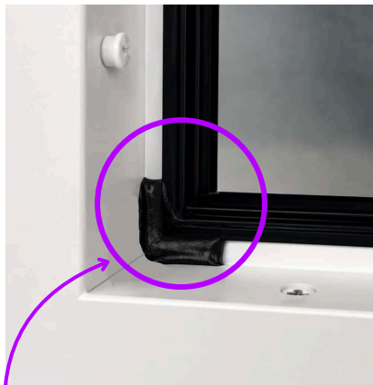
Hörn behandlat med mastix Hjørne behandlet med mastik
